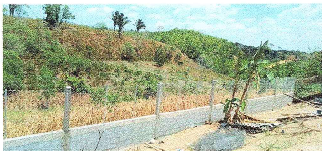
Foto 1: Aquí evidencia el proceso de finalización del muro de contención de block y malla.
