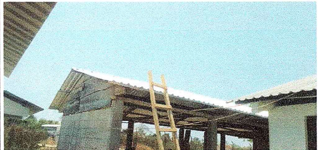
Foto 4: Es el proceso sobre el entechado de las aulas del establecimiento educativo.
