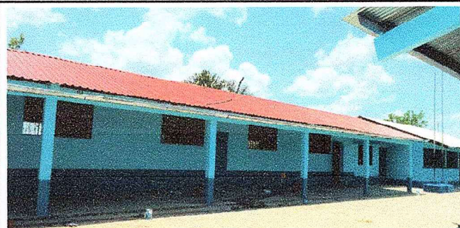
Foto 2: Aquí evidencia el proceso y a la vez la finalización de aplicación de pintura.
