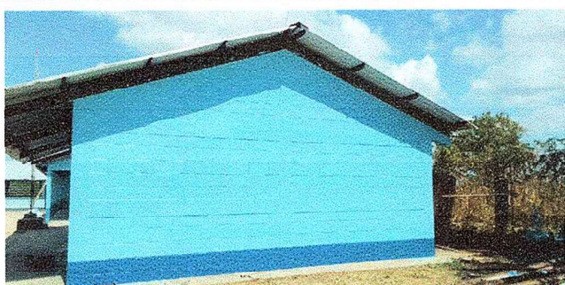
Foto 3: La fotografía evidencia la ejecución de pintura en la pared de las aulas.
