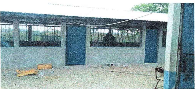
Foto 5: En esta fotografía evidencia el cambio de balcones y puertas.
